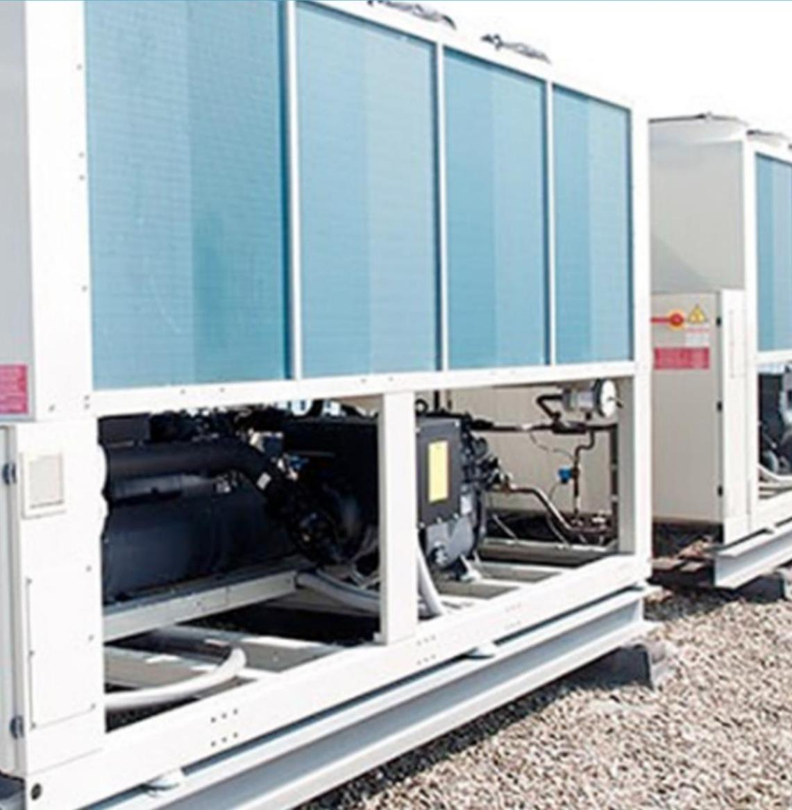
*Remplacement d'un groupe froid standard par un groupe froid avec haute et basse pression flottante et récupération de chaleur*
